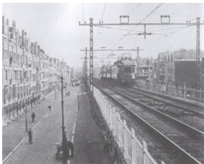
Het rijtuig in de jaren '20 op het viaduct
