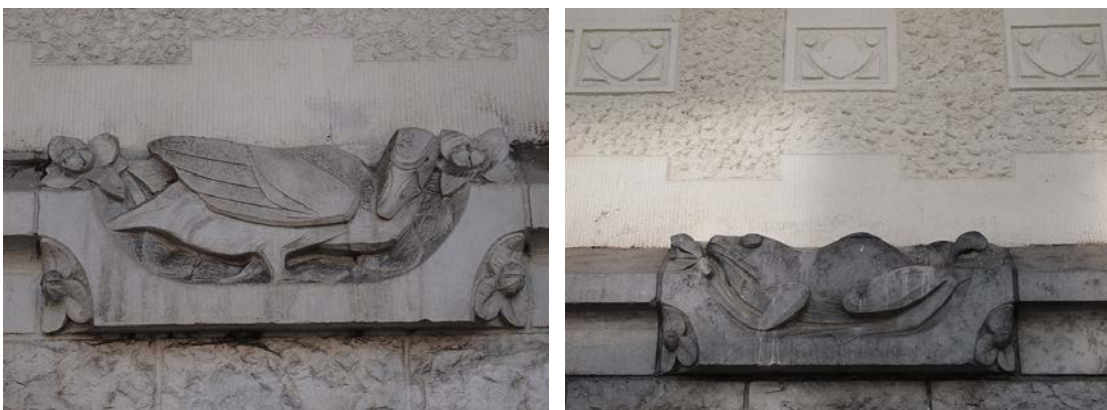
Reliëfs in jugendstil op de lange zijkanten van het viaduct
