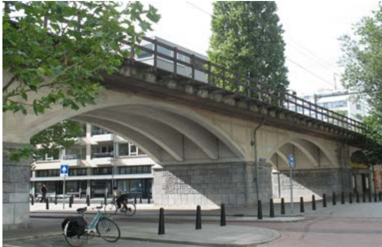
Enkele bogen van het 2 km lange viaduct in Rotterdam-Noord
